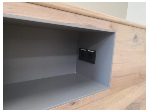
Tribünenintegrierte Steckdosen
