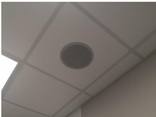
Deckenintegrierte Lautsprecher
