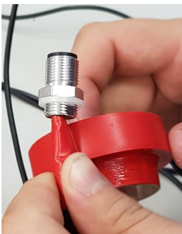
Abbildung 46: Isolation der Lötstelle
