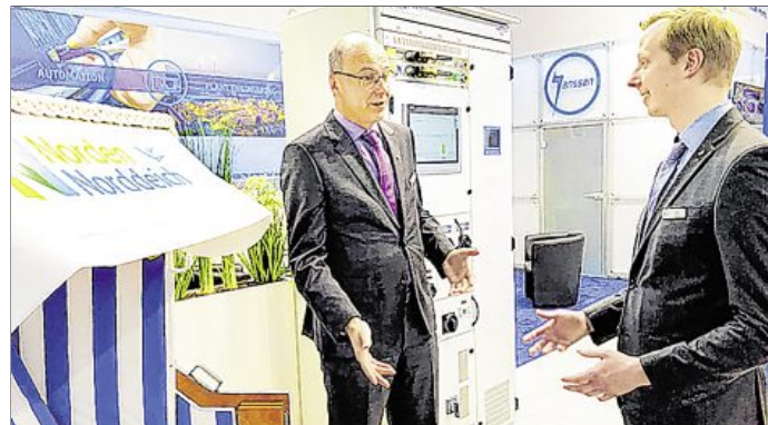
Jochen Peipp (links) und Willm Janssen von Rolf Janssen Elektrotechnische Werke aus Aurich tauschen sich auf der Hannover Messe vor einer Schaltanlage aus.
